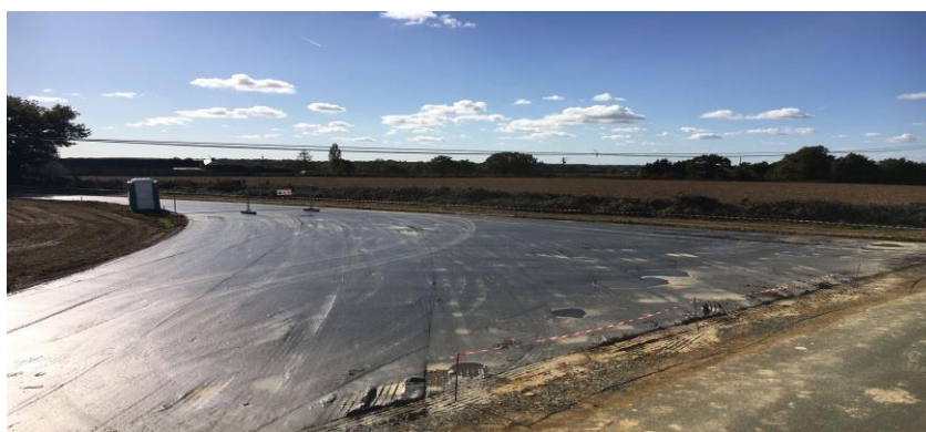
chemin E4 et E5 bitumage à la lance.
